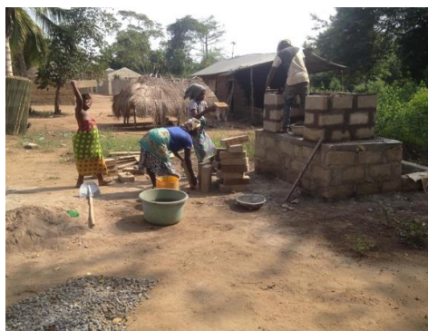
図6: アティテコベ村トイレ建設事業
